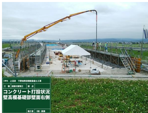
基礎部コンクリート打設状況
