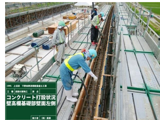
基礎部コンクリート打設状況
