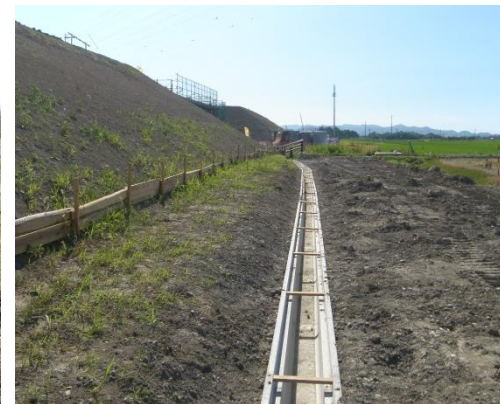
排水構造物設置(新設)状況
