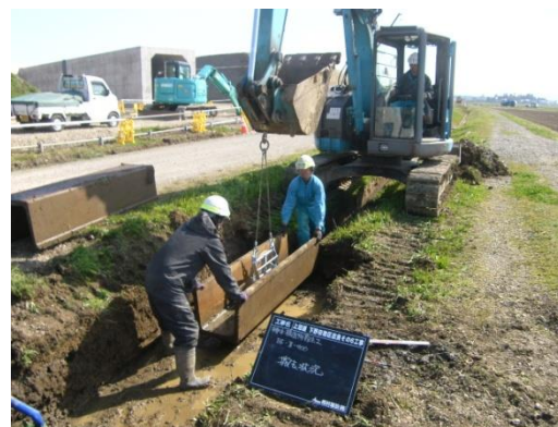
排水構造物撤去状況
