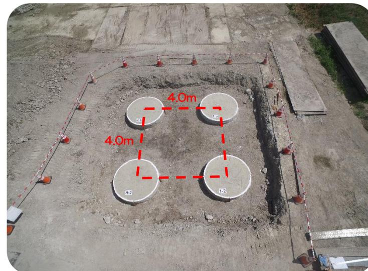
固結工(スラリー攪拌) 施工完了 (改良長 L=20.0m)
