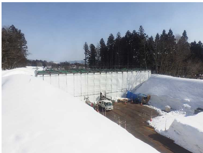
カルバート工 全景
