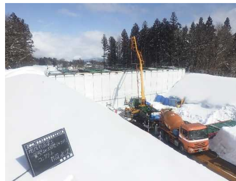
施工状況 (翼壁・土留壁コンクリート打設)
