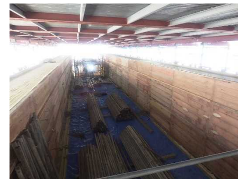
施工状況 型枠解体(雪寒仮囲い内部)
