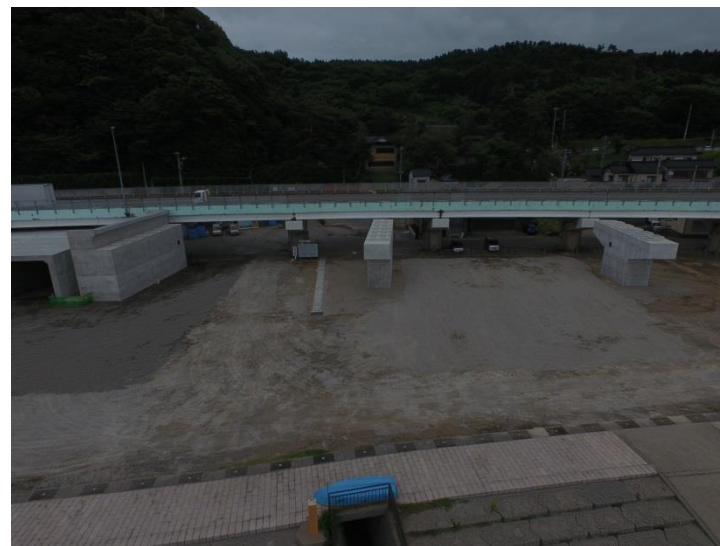
海側より施工区間望む
