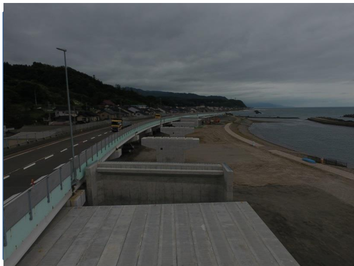
A1橋台からP2橋脚を望む
