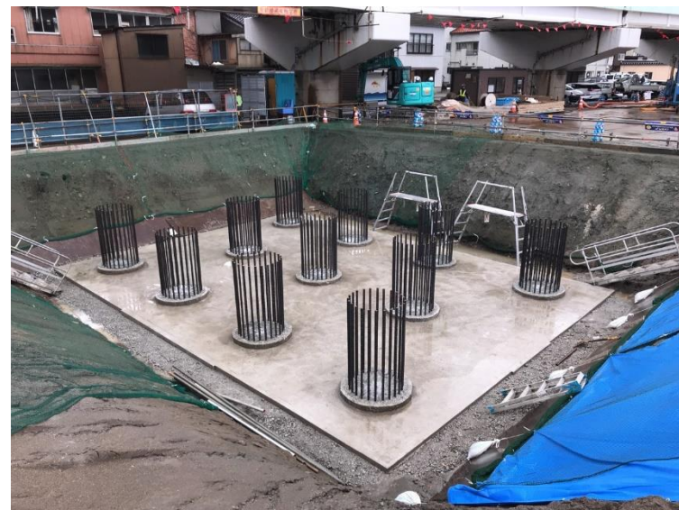
P3橋脚-杭頭処理完了
