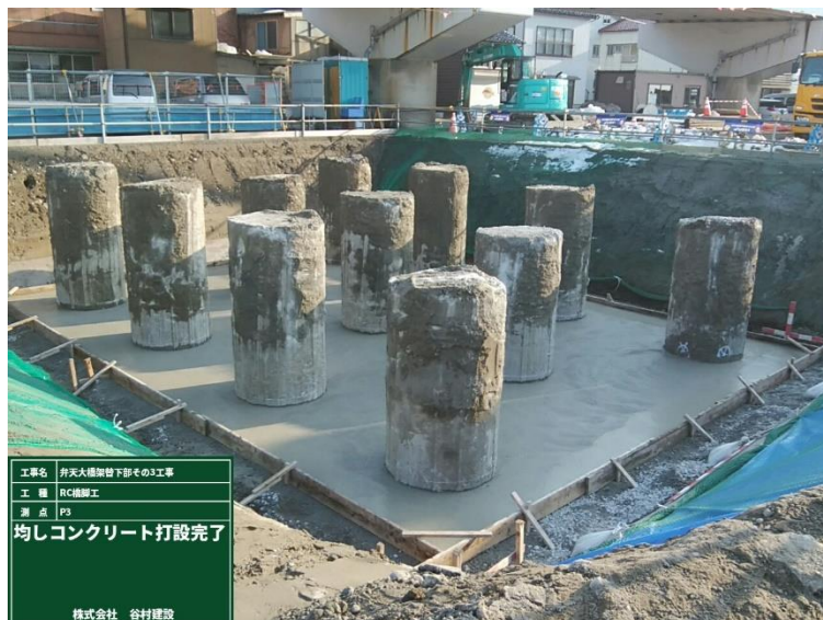
P3橋脚-場所打杭施工完了
