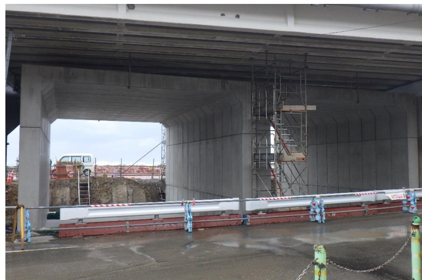
ボックス据付完了山側より望む
