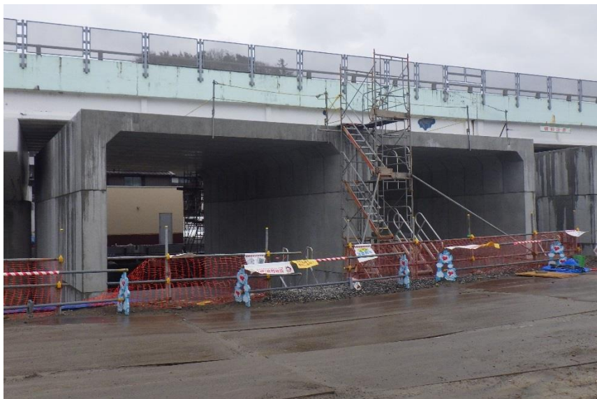
ボックス据付完了海側より望む
