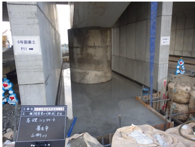
軽量盛土工・基礎工・湛水養生中 (P11橋脚・山側より)
