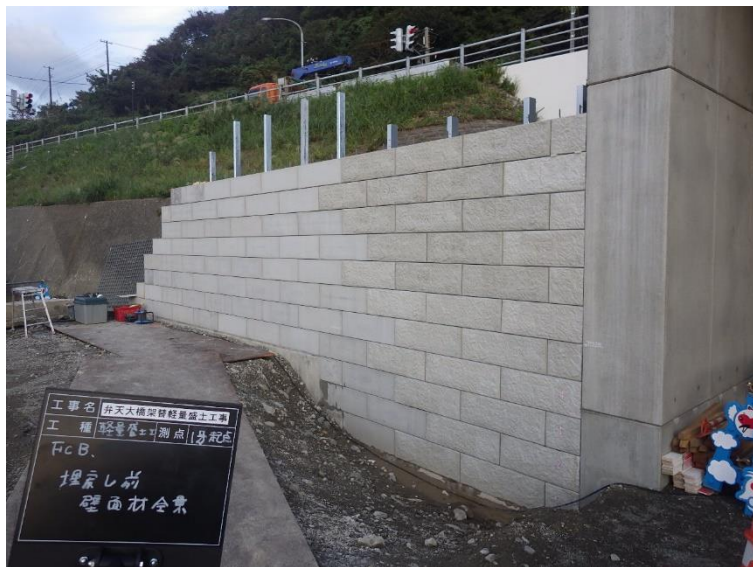
軽量盛土工・壁面材埋戻前全景 (1号函渠・起点・海側より)
