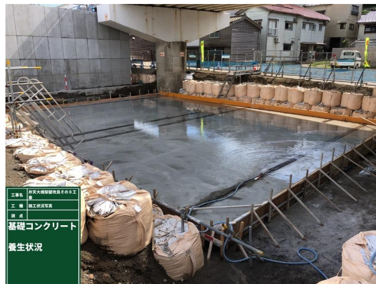
基礎コンクリート打設完了後養生状況
