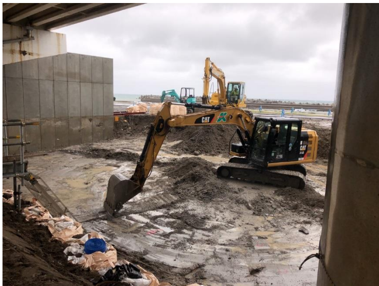
カルバート工 掘削・床付け状況
