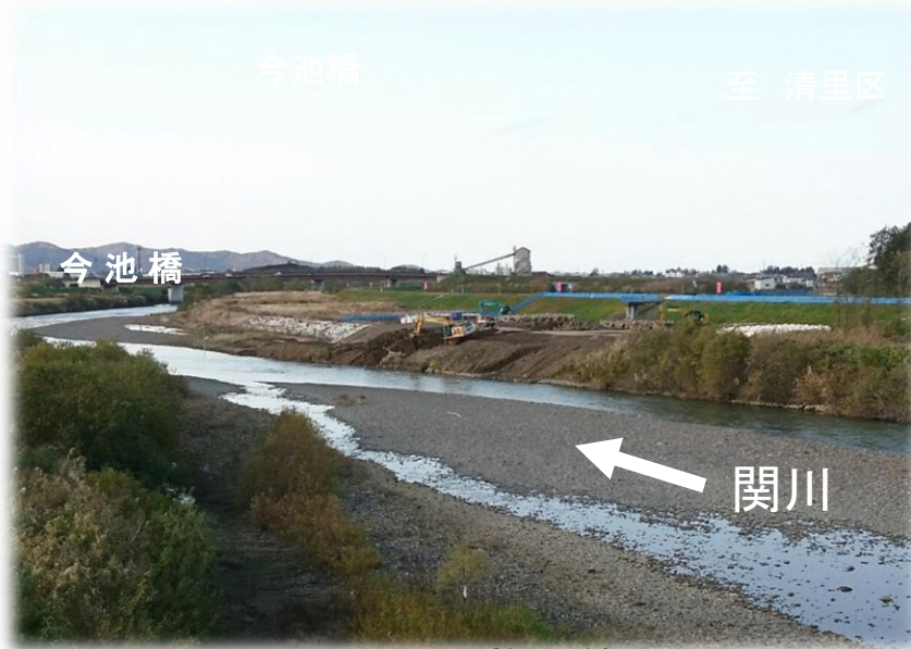
今池地区施工箇所
