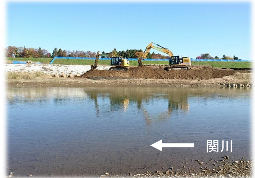
仮締切設置状況
