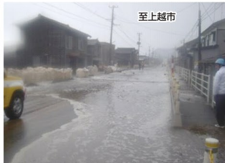
至上越市 越波による通行止め 平成20年2月(中宿周辺)
