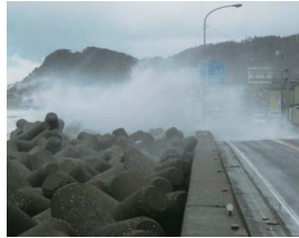
国道8号の越波の状況(糸魚川市能生地先)
