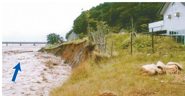
平成7年7月 姫川出水 糸魚川市大野地先 堤防決壊状況
