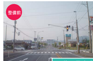
国道8号寺島電線共同溝の整備
