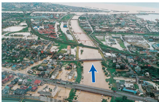
平成7年7月 保倉川出水・浸水状況
