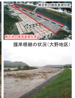
姫川出水状況(大野地区)
