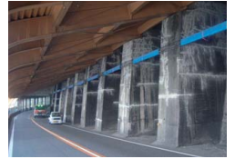
向山7号洞門(山側擁壁の補修状況)
