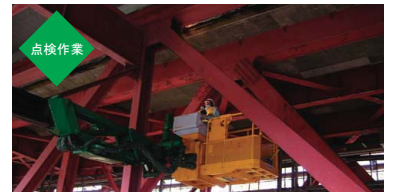
橋梁点検(国道18号 郷田切橋)
