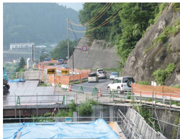
国道148号(小谷道路) 改良箇所の状況
