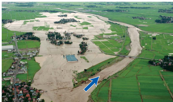
平成7年7月 関川出水 妙高市月岡地先堤防決壊状況
