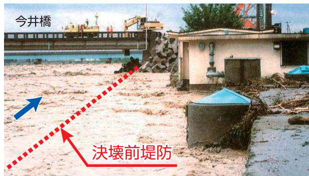
平成7年7月 姫川出水 糸魚川市上刈地区の堤防決壊状況
