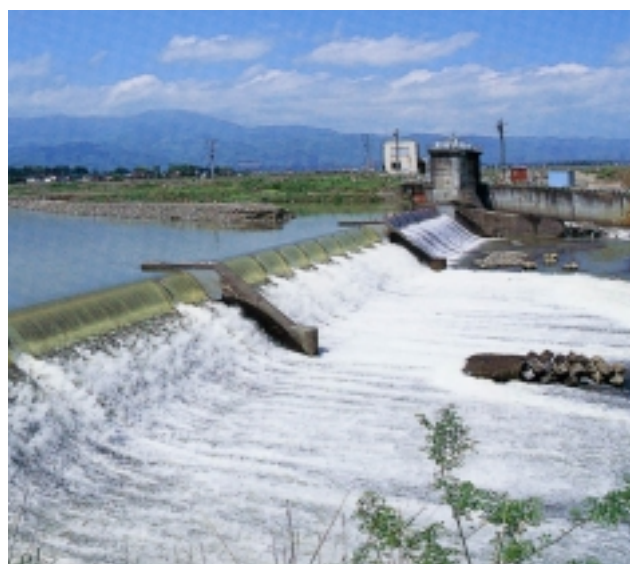
関川に設けられた農業用水の取り入れ口 (7.11水害を契機に改築中)
