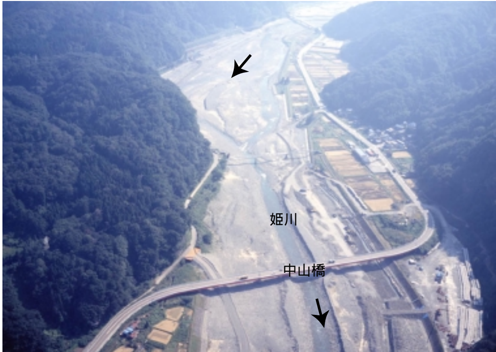
中山橋付近（河口から6.8～7.5km） 【平成9年10月3日撮影】
