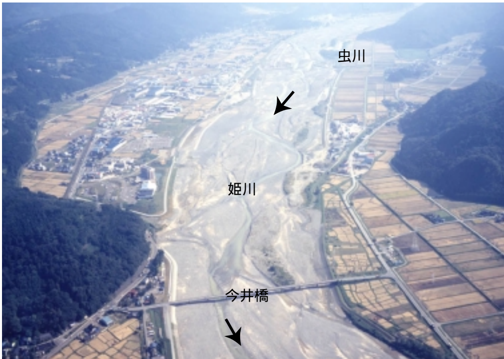
今井橋付近（河口から2.0～3.0km） 【平成9年10月3日撮影】
