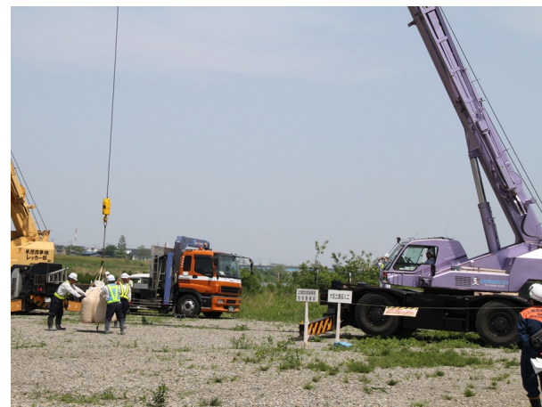
●大型土のう投入工
