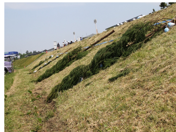
●木流し工－訓練完了
