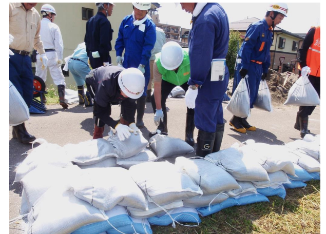
●市民積み土のう工－土のう据付
