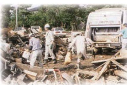
洪水後の跡片付け状況
