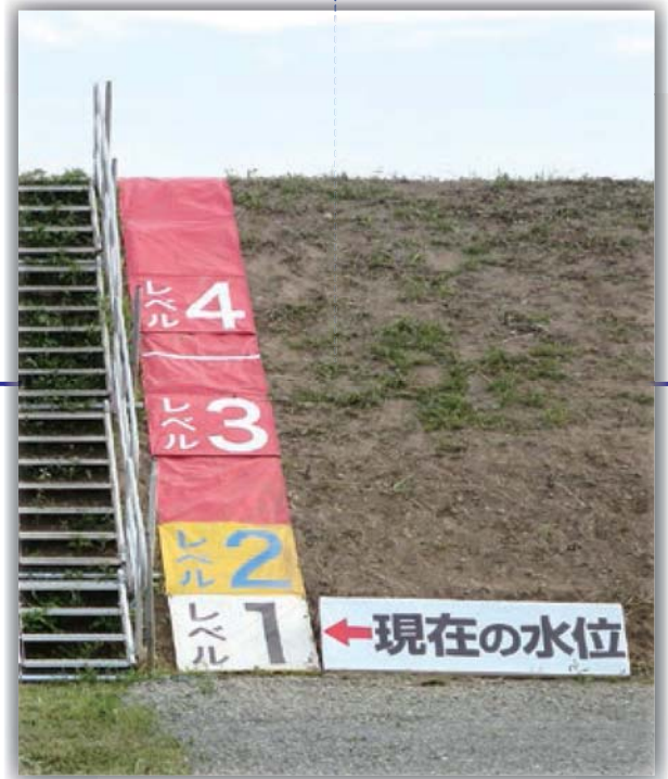
洪水危険レベル表示
