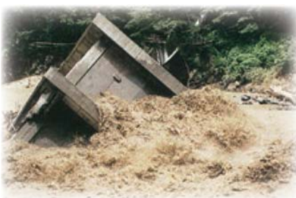
糸魚川市平岩（施設被害状況）
