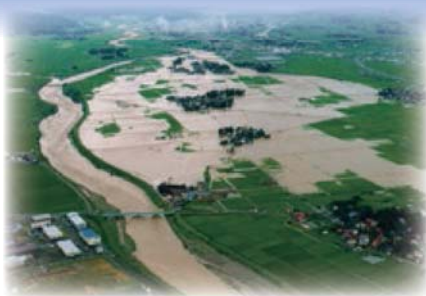
妙高市月岡地域（破堤状況）
