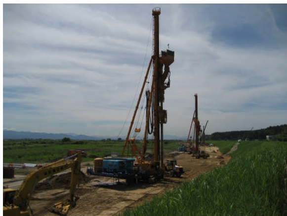
液状化対策工（静的締固砂杭工法）
