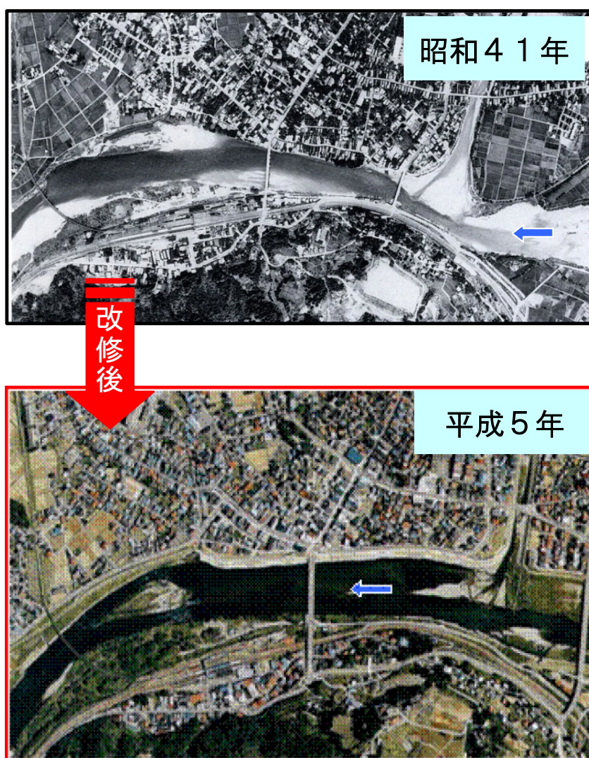
小出地区改修前後の状況
