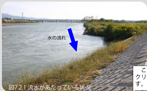
図7.2.1 流水があたっている状況
