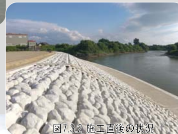
図7.3.2 施工直後の状況
