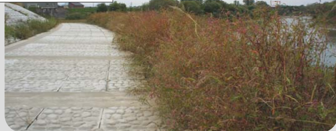
図7.3.3 施工後1年3ヶ月後の状況
