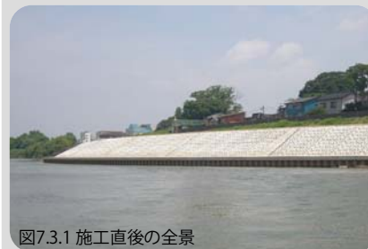
図7.3.1 施工直後の全景
