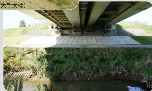
図6.3.2 日影の多い橋の下 (写真は大手大橋)
