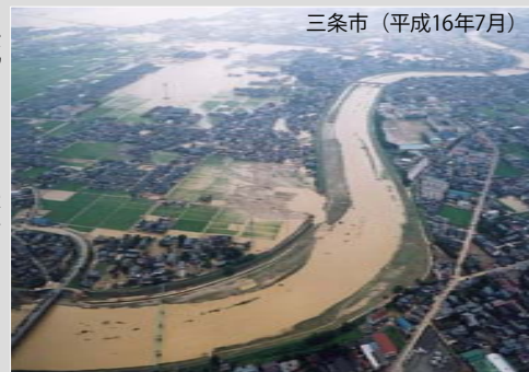
図6.1.3 破堤した堤防
