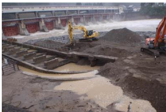
中規模出水後の魚道土砂堆積【復旧作業】
