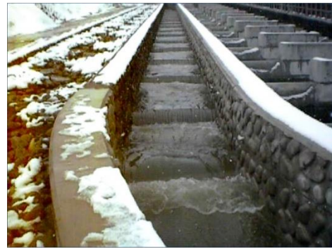
改築直後の流況
