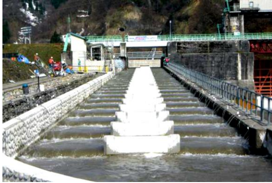
対策工設置後の流況
