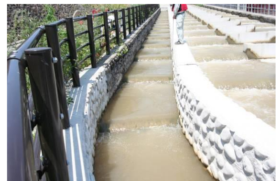
対策工設置後の流況
