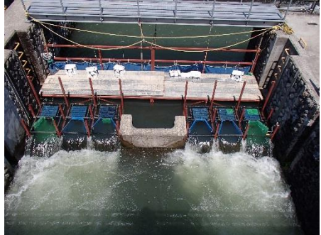
捕獲カゴ設置状況（大型魚道）
