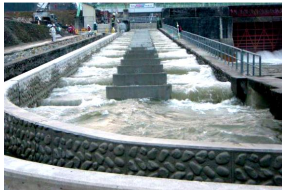
改築直後の流況
