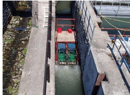
捕獲カゴ設置状況（小型魚道）
