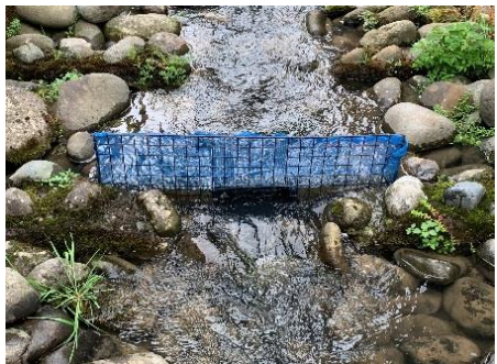
捕獲カゴ設置状況（せせらぎ魚道）
