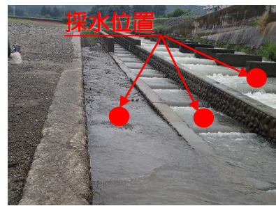
魚道下流端採水位置
