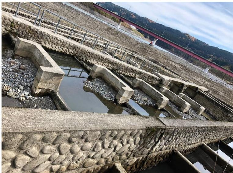
V 暫定通水時の大型魚道内の堆積状況
