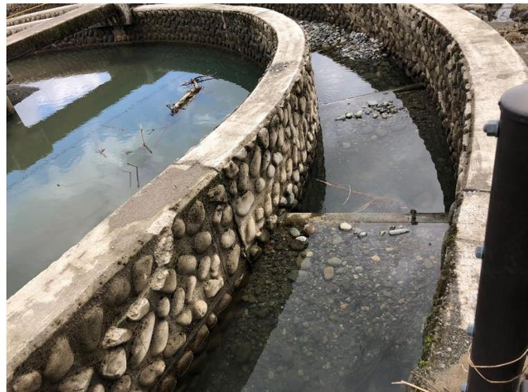
VI 暫定通水時の小型魚道内の土砂堆積状況
