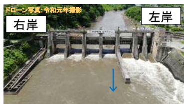
【西大滝ダム自然河川状態】
