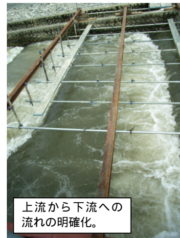
玉石・土嚢投入後
