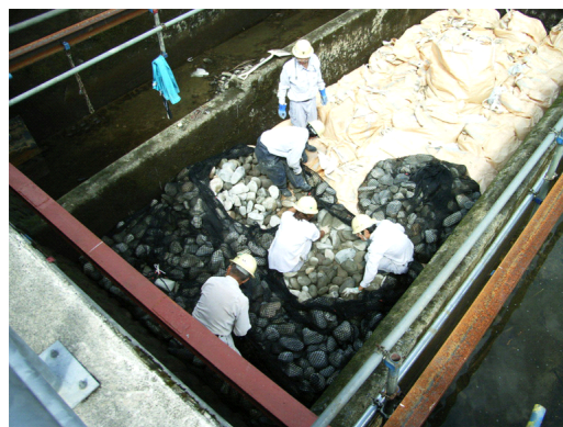
玉石・土嚢の投入
