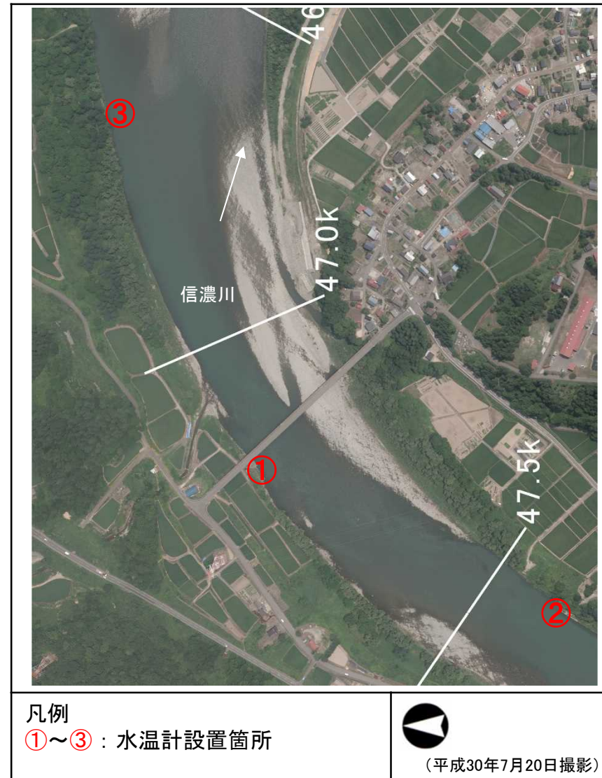
川井大橋水温計設置箇所
