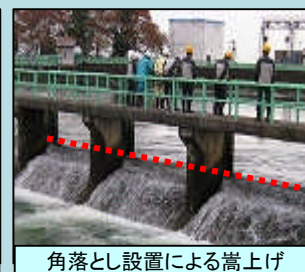
角落とし設置による嵩上げ
