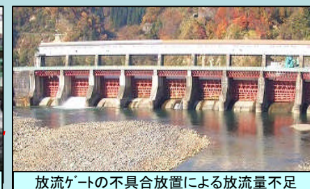
放流ゲートの不具合放置による放流量不足
