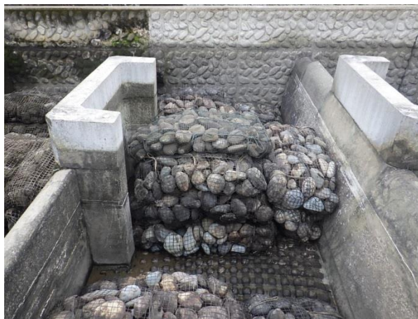
通常時のカゴ詰め玉石工の状況 （健全な状況）
