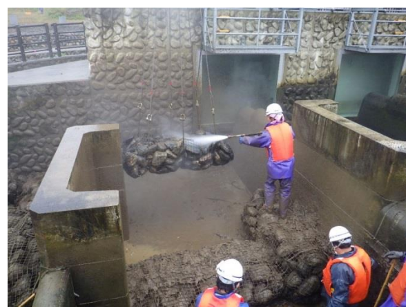
カゴ詰め玉石工の清掃状況
