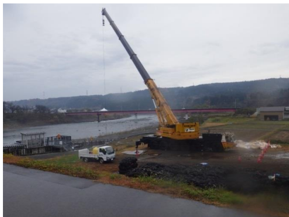
200トンラフタークレーンを使用しての作業
