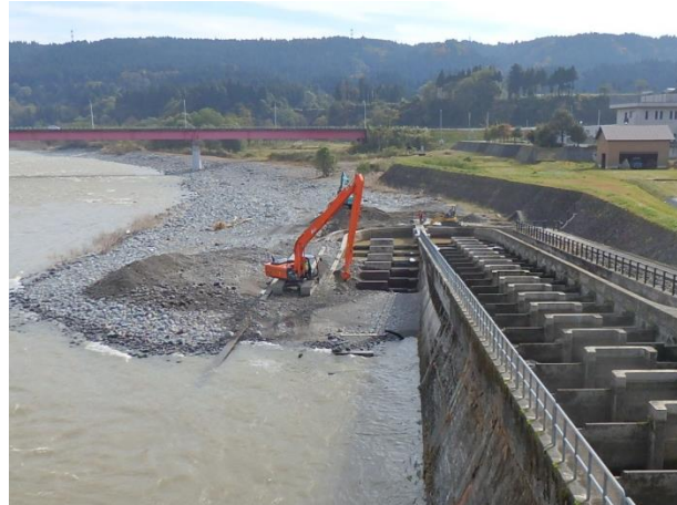
魚道折返し部下流方の復旧作業状況
