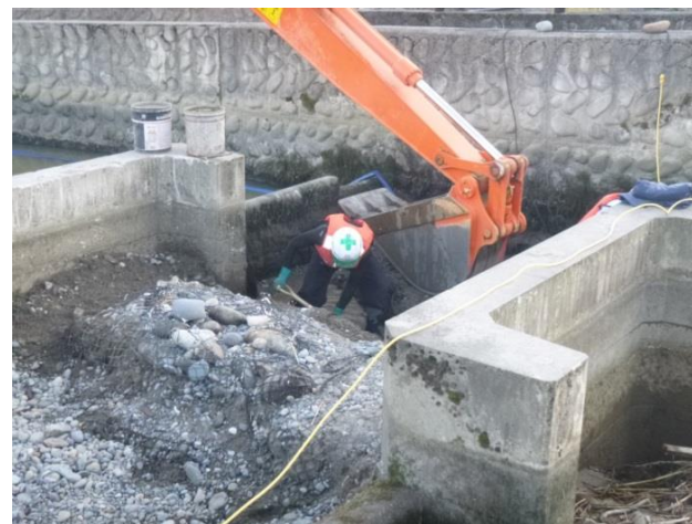
魚道折返し部上流方の人力作業の状況
