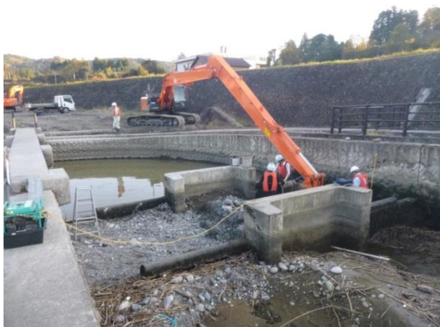
魚道折返し部上流方の復旧作業状況
