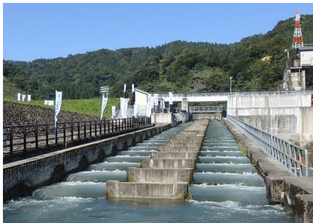
通常時の魚道の状況 （健全な状況）
