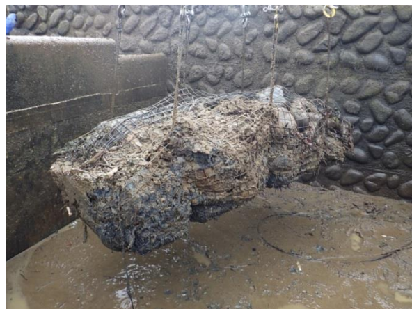
清掃前のカゴ詰め玉石工の状況
