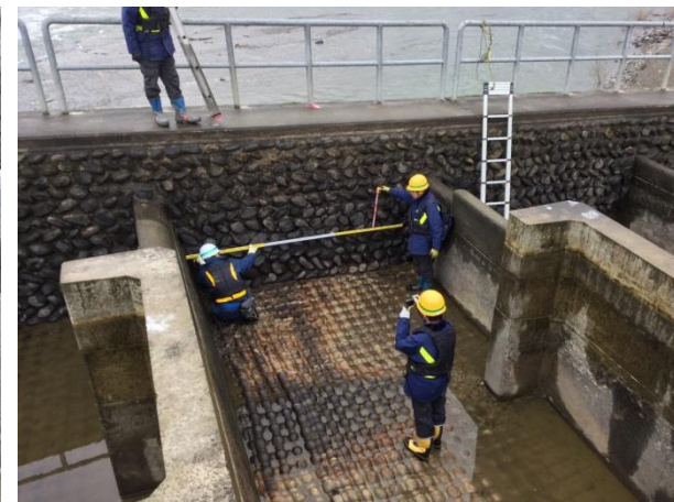
検査実施状況（大型魚道）
