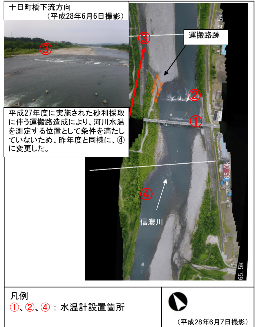
十日町橋水温計設置箇所詳細
