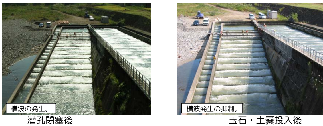
図 7.2-6 試験施工の実施状況(横波の発生状況)
