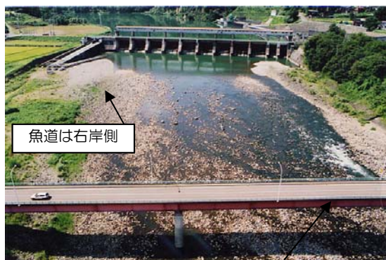
図 7.2-1 濡筋と魚道の位置
