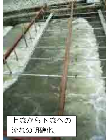
玉石・土嚢投入後
