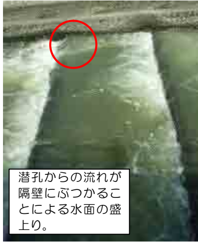
玉石・土嚢投入前
