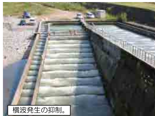
玉石・土嚢投入後
