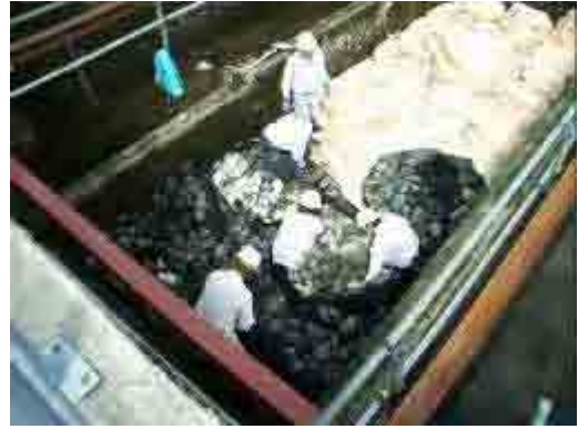
玉石・土嚢の投入
