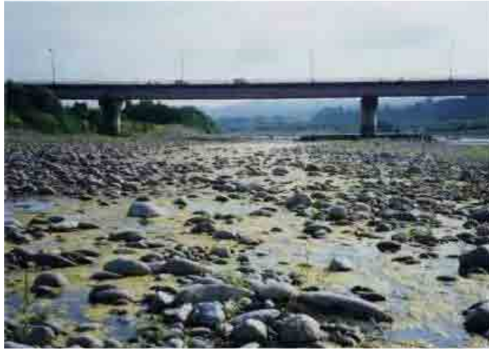
写真 2 腐敗した付着藻類(妻有大橋付近：2002 年 7 月 8 日撮影)
