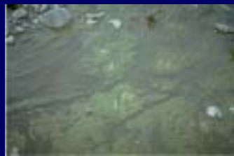
1回目 妻有大橋 中央測線(71.9m地点)
