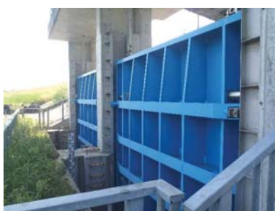
排水樋門稼働状況
