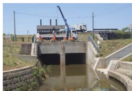
国による排水ポンプ車の訓練状況
