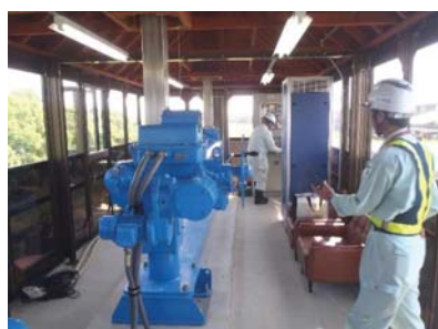
三条市による樋門の操作訓練状況
