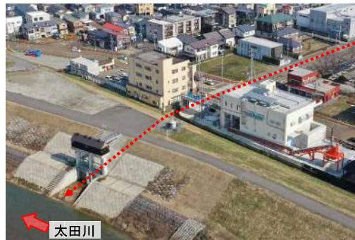
柿川放水路排水機場(右):長岡市幸町 柿川放水路樋門:(左):長岡市左近
