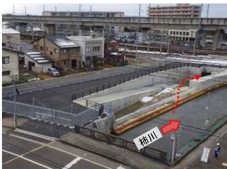
越流堤:長岡市金房
