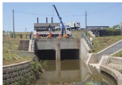
国による排水ポンプ車の訓練状況
