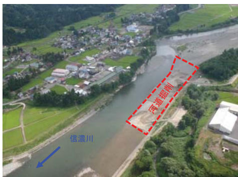
河道掘削：小千谷市岩沢地区
