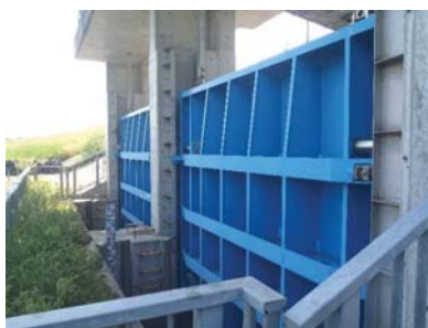
排水樋門稼働状況
