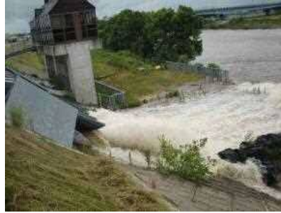
排水機場・排水ポンプの排水状況
