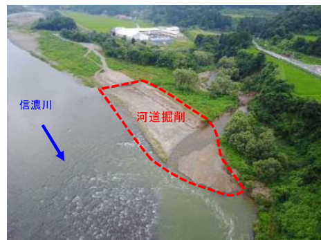
河道掘削：小千谷市岩沢地区
