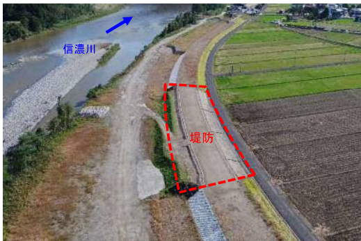
堤防整備・浸透対策：小千谷市川井地区
