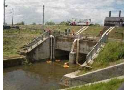
国による排水ポンプ車の訓練状況
