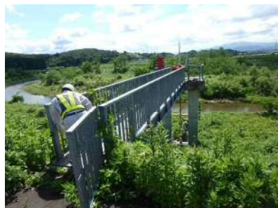
各種門の作動状況・安全確認
