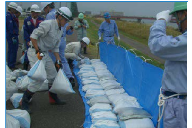
「改良積土のう工」
