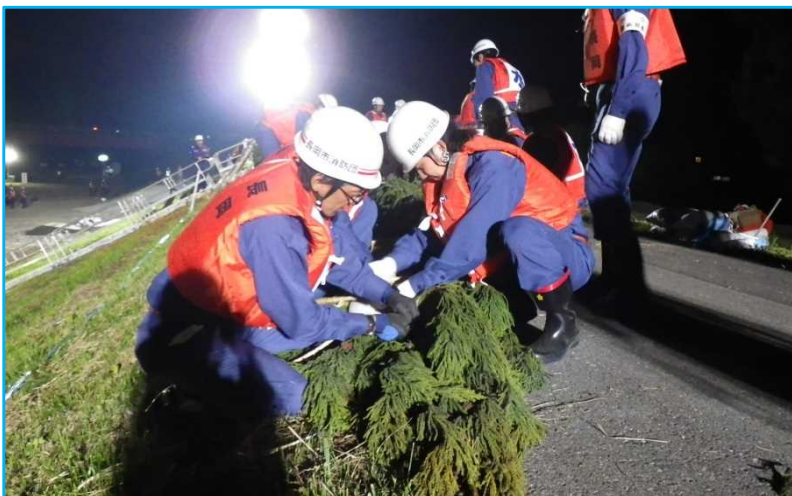
平成27年度 実施の様子（木流し工）
