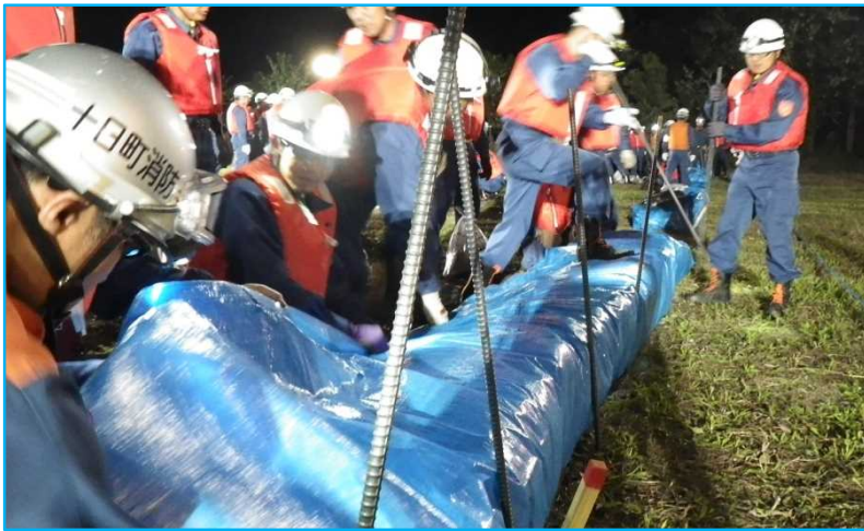
平成27年度 実施の様子（改良積み土のう工）
