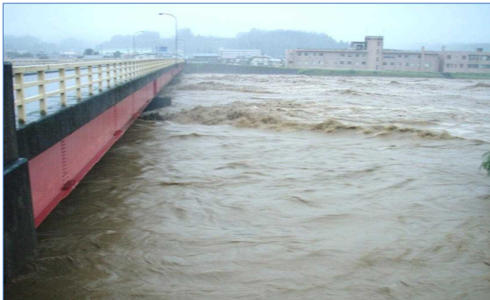
『平成23年7月新潟福島豪雨』 魚野川 根小屋橋右岸から [H23,7,30撮影]
