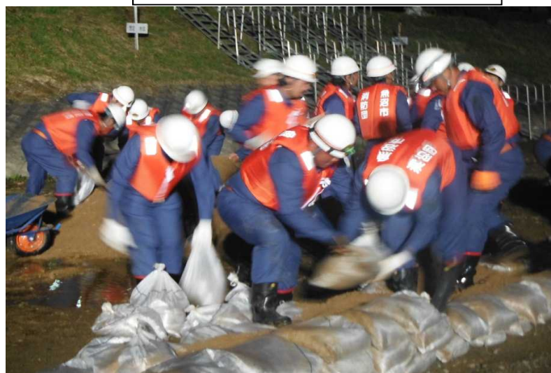
平成26年度 実施の様子（積み土のう工）
