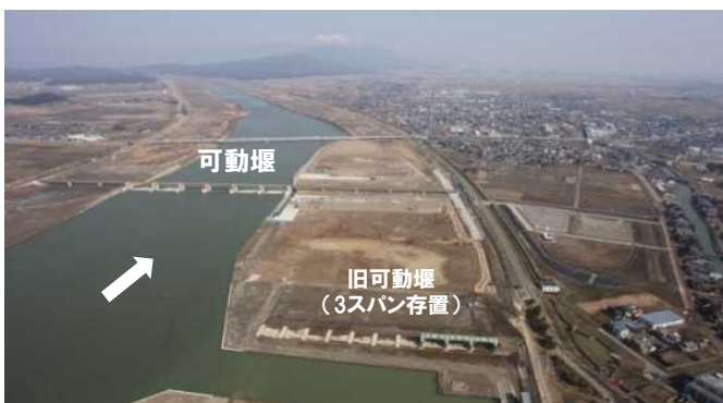
完成した可動堰改築事業（H26.3.24）
