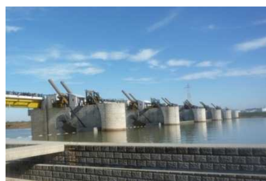
可動堰ゲート（左岸上流より）
