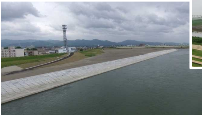
完成した護岸・高水敷（H26.4.25）
