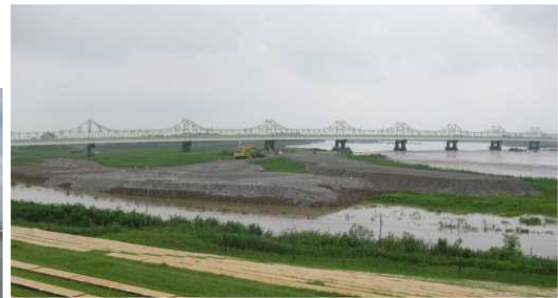
仮設準備中の工事現場 （H25.7.30）
