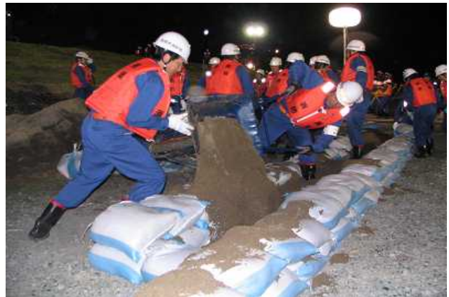
平成25年度 実施の様子（積み土のう工）
