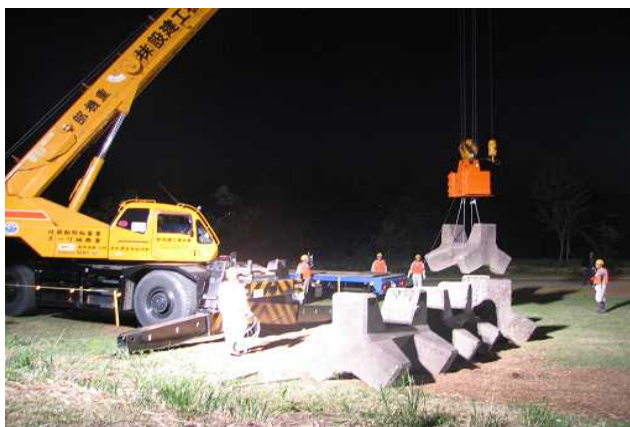
平成25年度 実施の様子（ブロック投入工）
