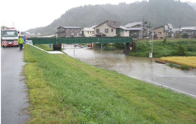
写真-1 台風18号出水による県道冠水状況
