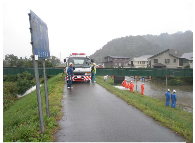
写真-2 排水ポンプ車による排水作業状況
