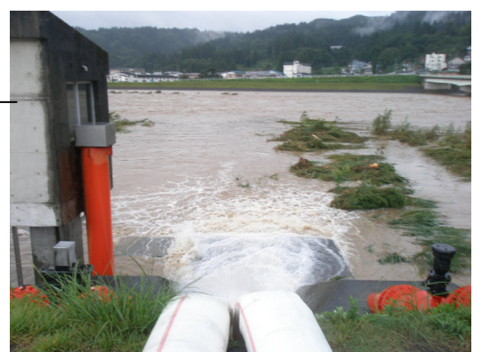
明神樋管付近での排水ポンプ車による内水排除作業
