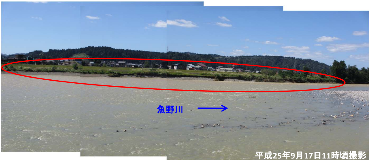
②魚野川左岸 魚沼市和長島地先 河岸洗掘
