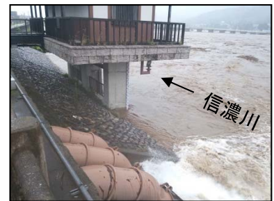
平成25年9月16日16時頃撮影 排水ポンプによる排水状況
