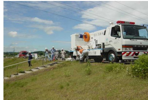
【排水ポンプ車設置状況】
