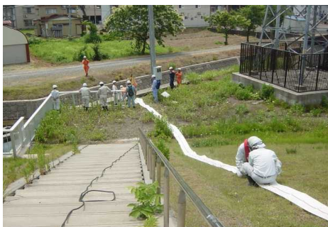
【排水ホース設置状況】
