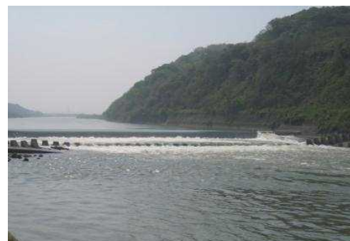
大河津分水路 第二床固(下流から望む)
