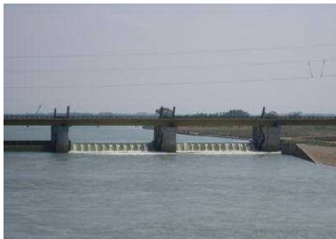
可動堰の放流状況(通常時下流から望む)
