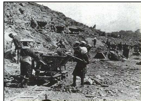
分水工事(当時)の状況写真
