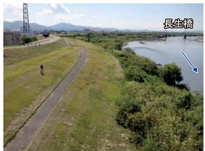
緩傾斜堤防の事例(長生橋下流)
