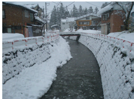
導水後の与越川の状況（平成24年12月12日撮影）
